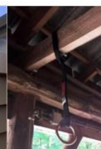
C VERANKERINGS PUNT IN GEBOUW
